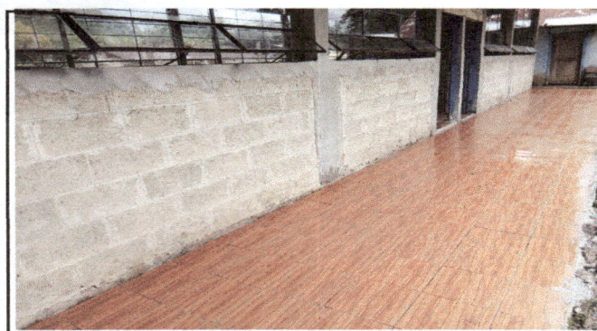
Foto 3: Se instaló piso cerámico en el corredor del establecimiento educativo.
