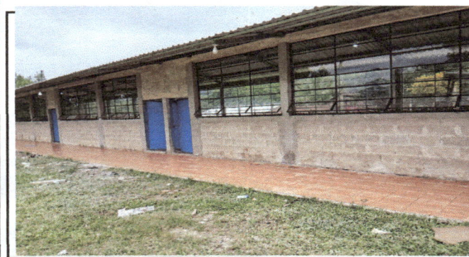
Foto 5: La instalación de piso cerámico y ventanas de balcones con vidrios frente las tres aulas.
