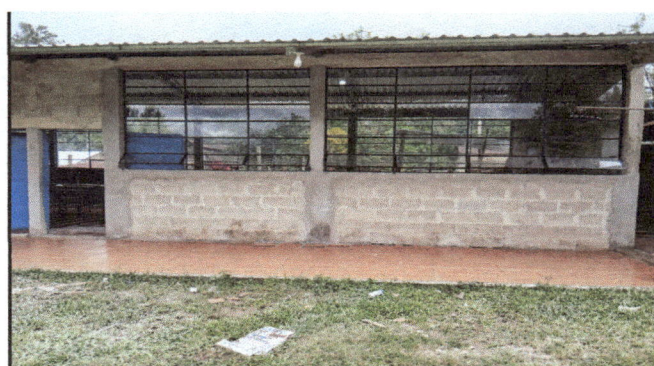
Foto 4: Panorama del piso cerámico y ventanas de balcones con vidrios.
